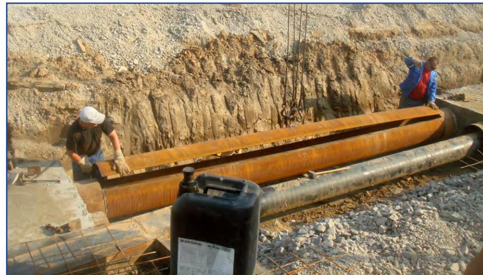
Устройство защитного кожуха из металлической трубы
