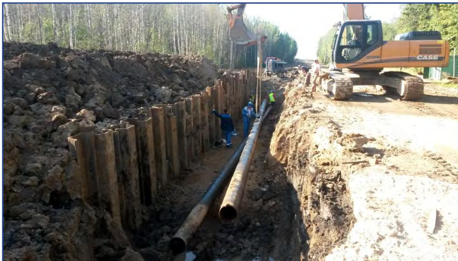
Укладка трубопровода в котловане,
