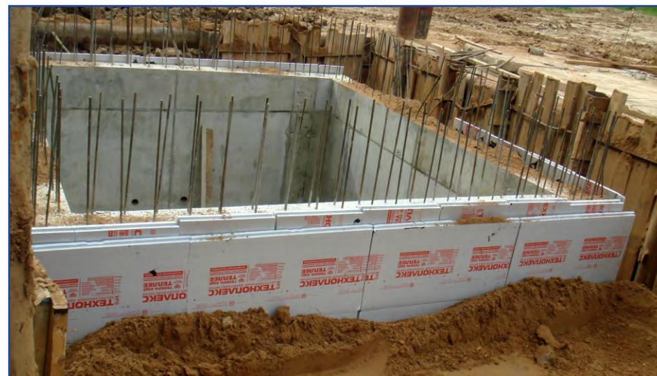
Устройство теплоизоляции и обратная засыпка
