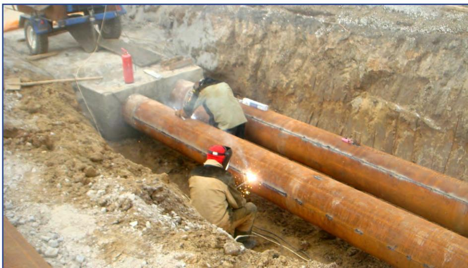
Сварка металлического кожуха с полным проваром
