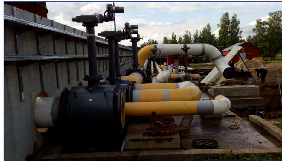
Монтаж задвижек с электрическим приводом
